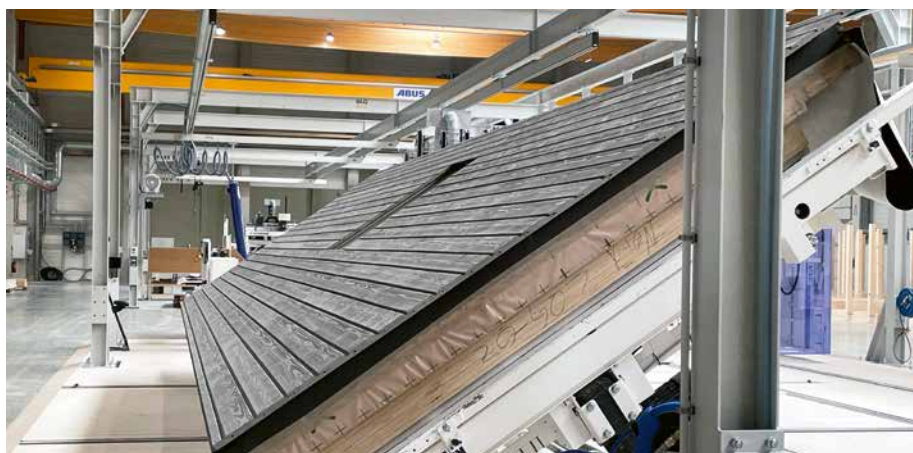
Serielle Fassadenfertigung bei B&O Holzbau GmbH in Frankfurt/Oder
